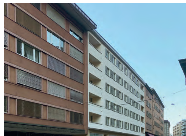
12: Baselstr. 80 (helles Gebäude), Lädelihof: Baselstr. 74+76 sowie Lädelistr. 23
